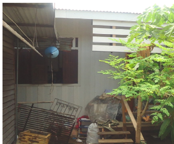
หลังซ่อม
