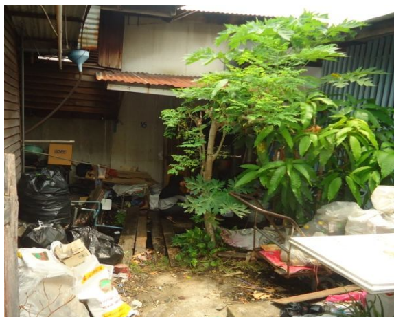
ก่อนซ่อม
