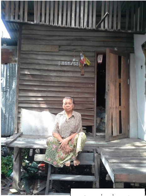
สภาพก่อนซ่อมแซม
