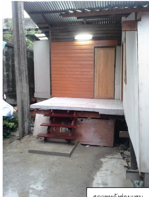
สภาพหลังซ่อมแซม
